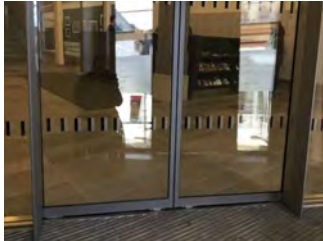
Windfangtür am Eingang
