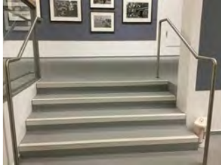
Treppe zwischen Ebene 2 und 3
